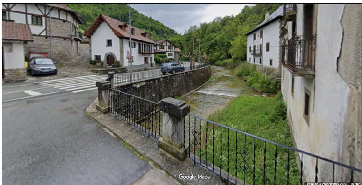
Figura 15. Zona del puente más aguas abajo de los dos existentes en la localidad. Se trata de uno de los primeros puntos en los que pueden iniciarse los desbordamientos.
